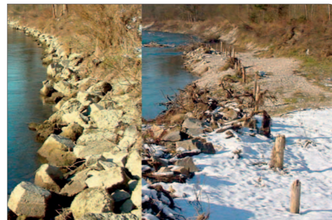
Aufweitung des Gewässerbetts / Uferbrücken (vorher/nachher)
