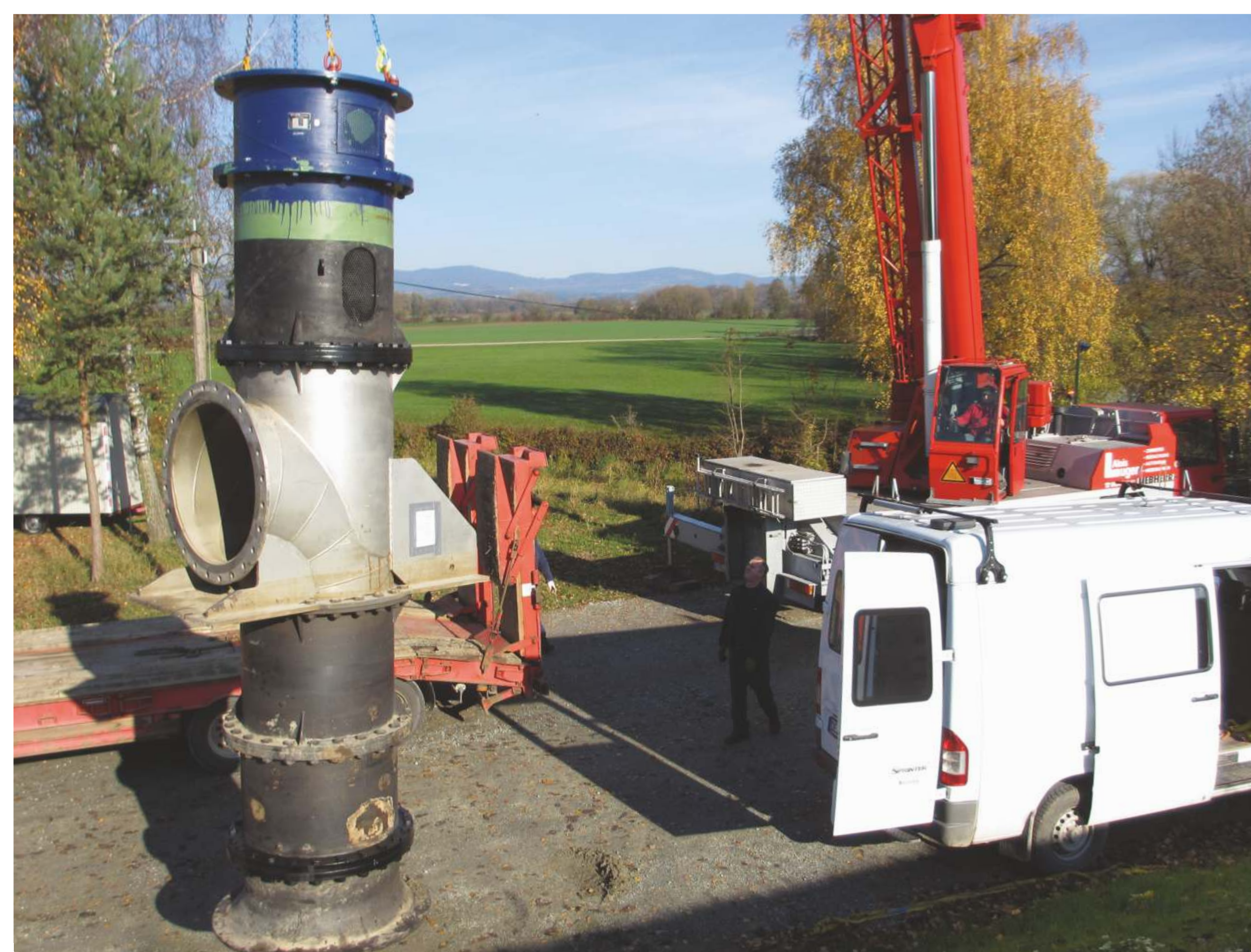
Abb. 2: Reparatur Pumpe Schöpfwerk Auerwörth
