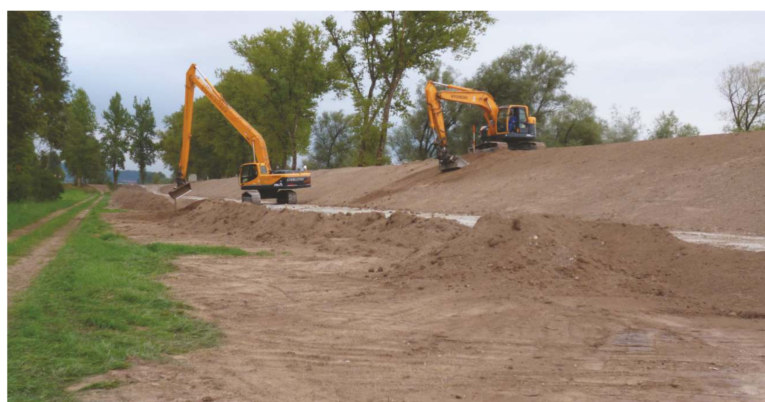
Abb. 1: Metten Deichsanierung Schalterbach
