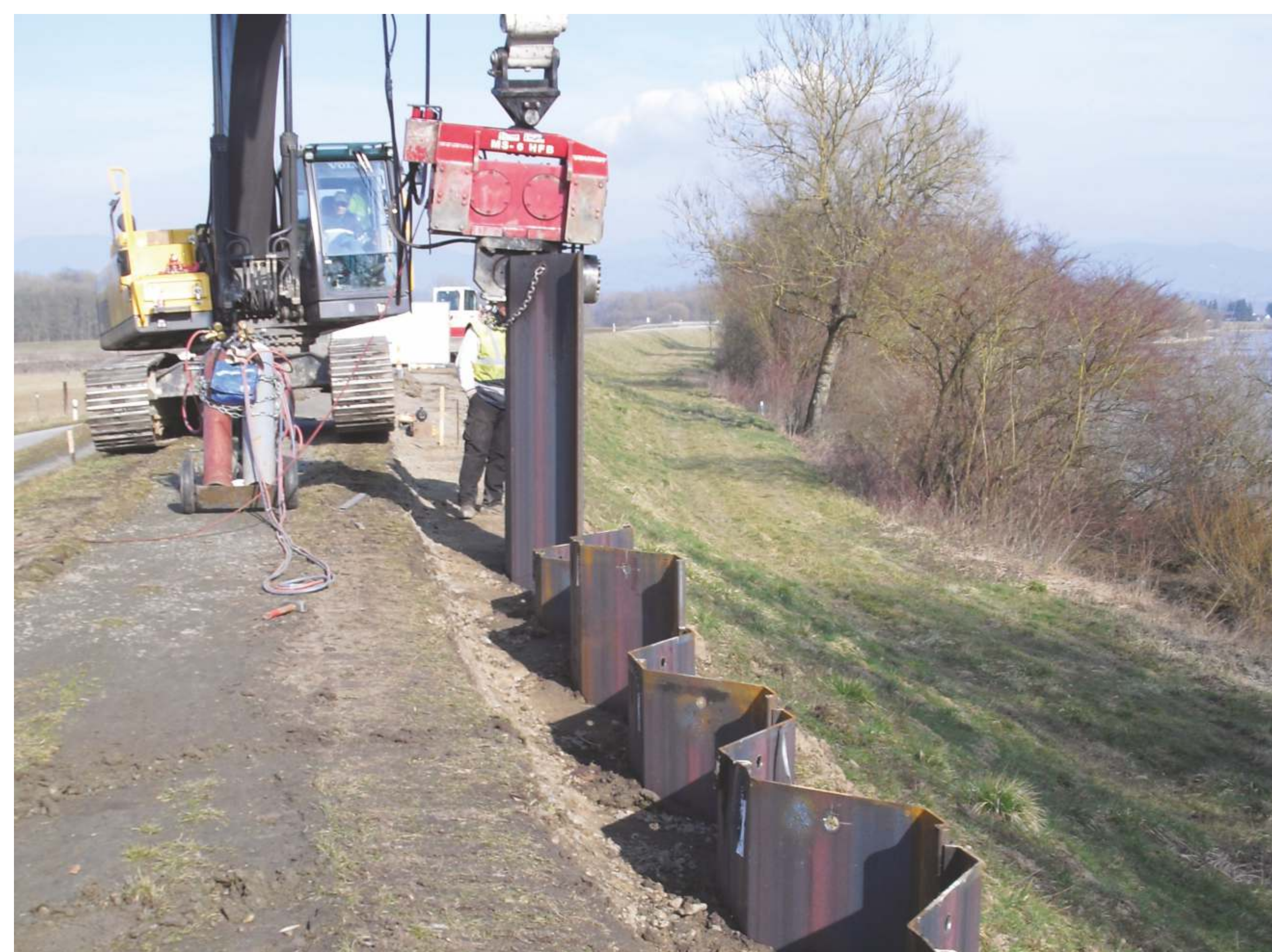
Abb. 2: Einbau Stahlspundwand bei Sommersdorf
