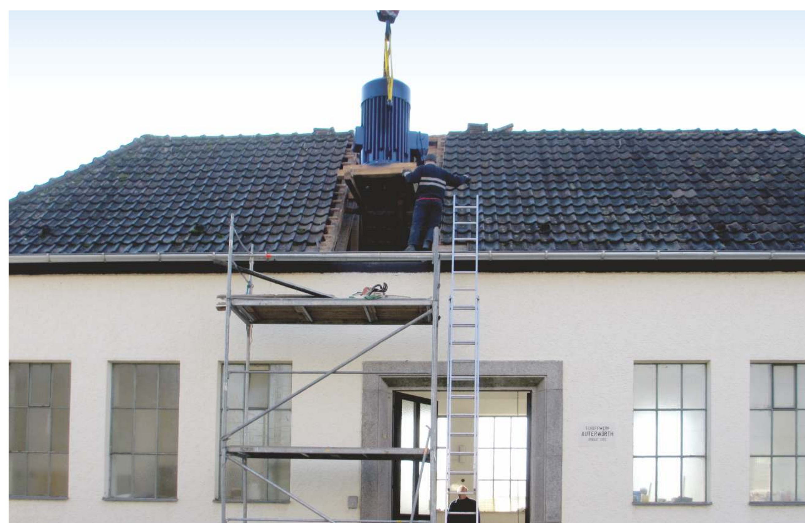
Abb. 1: Überholung Motor Schöpfwerk Auerwörth
