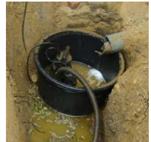
Abb. 6: Freilegen der Entwässerung, abpumpen und fachgerechtes entsorgen des Sickersaftes
