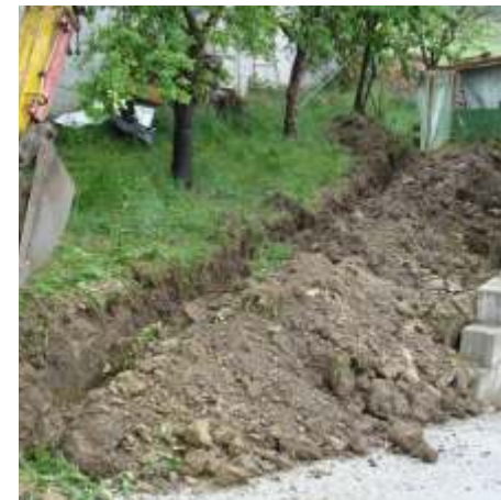
Abb 5: Freilegung der Entwässerung
