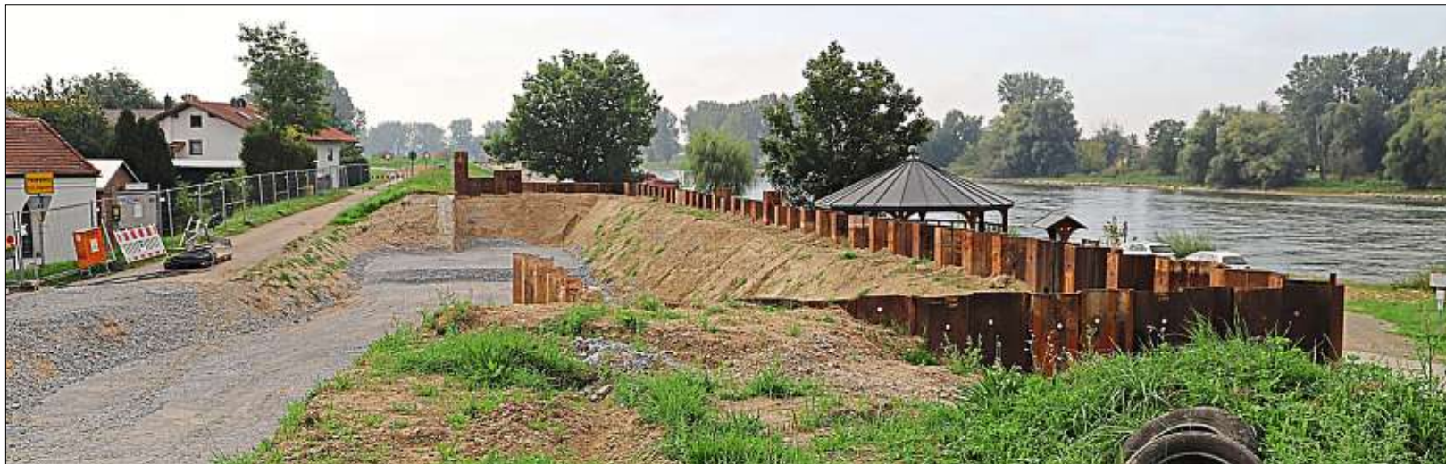
Die große Baugrube , wo ehemals die Zufahrt zur Niederalteicher Fähre war, war ein Stopp der Besichtigung. Hier wird derzeit der Betonbau für das Stemmtor vorbereitet, das im zweiten Quartal 2024 geliefert werden soll.
