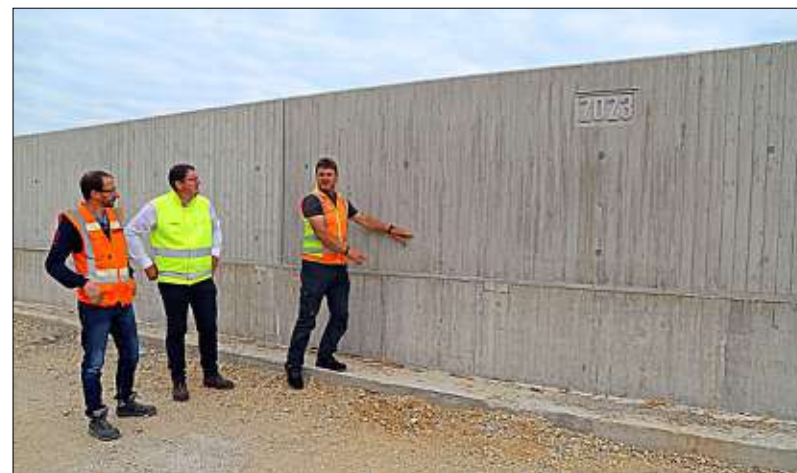
Die Hochwasserschutzmauer im Bereich der Autobahn ist weitestgehend fertig gestellt. Wie hoch der Deich noch aufgeschüttet wird, zeigte Robert Wölfl (r.) von der örtlichen Bauüberwachung der WIGES.
