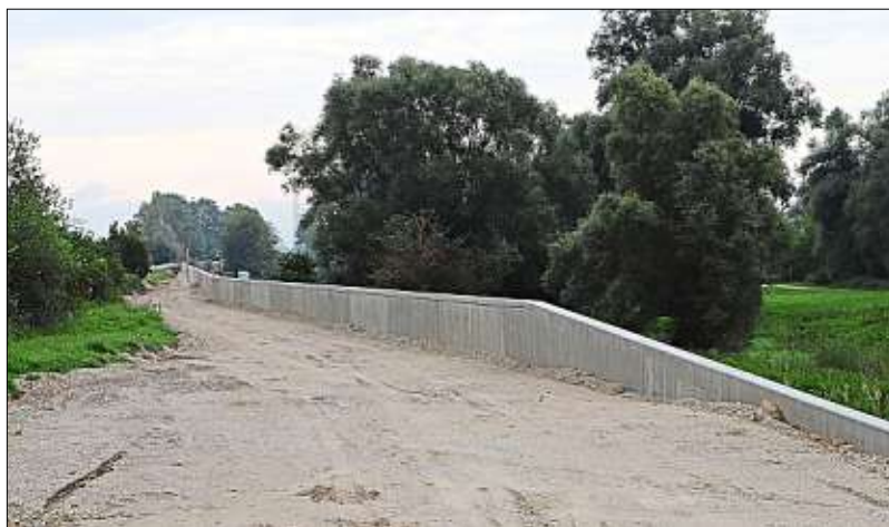
In den Bereichen , wo zu wenig Platz für einen richtigen Deich ist, greift man beim Hochwasserschutz auf Betonwände zurück. So will man verhindern, zu weit in das Deichvorland einzudringen.
