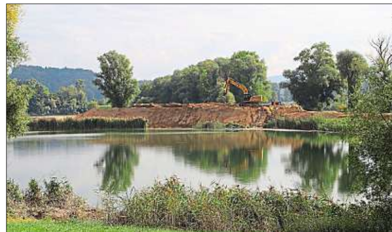
Neben verschiedenen ökologischen Ausgleichsmaßnahmen wird am Luberweiher eine Eisvogelwand gebaut.
