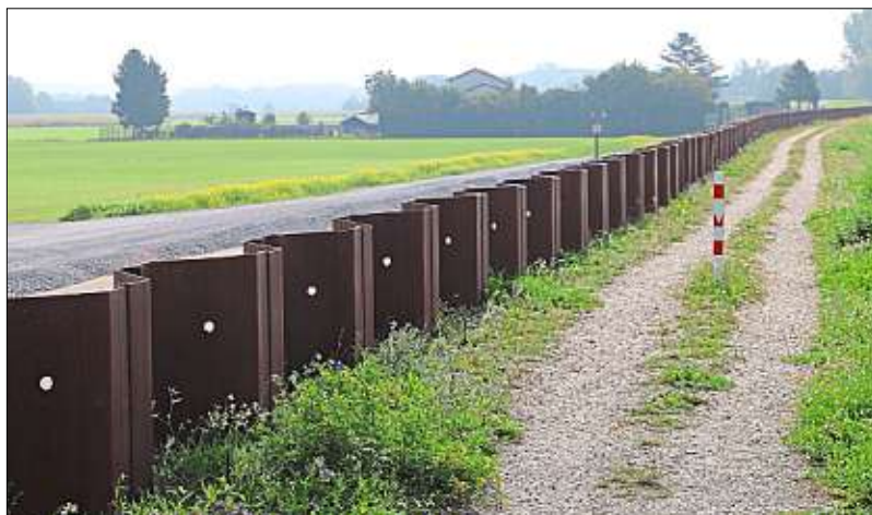
Alle Spundwände , die derzeit wie hier in Richtung Kläranlage noch zu sehen sind, werden bis zum Abschluss der Maßnahme verschwinden.
