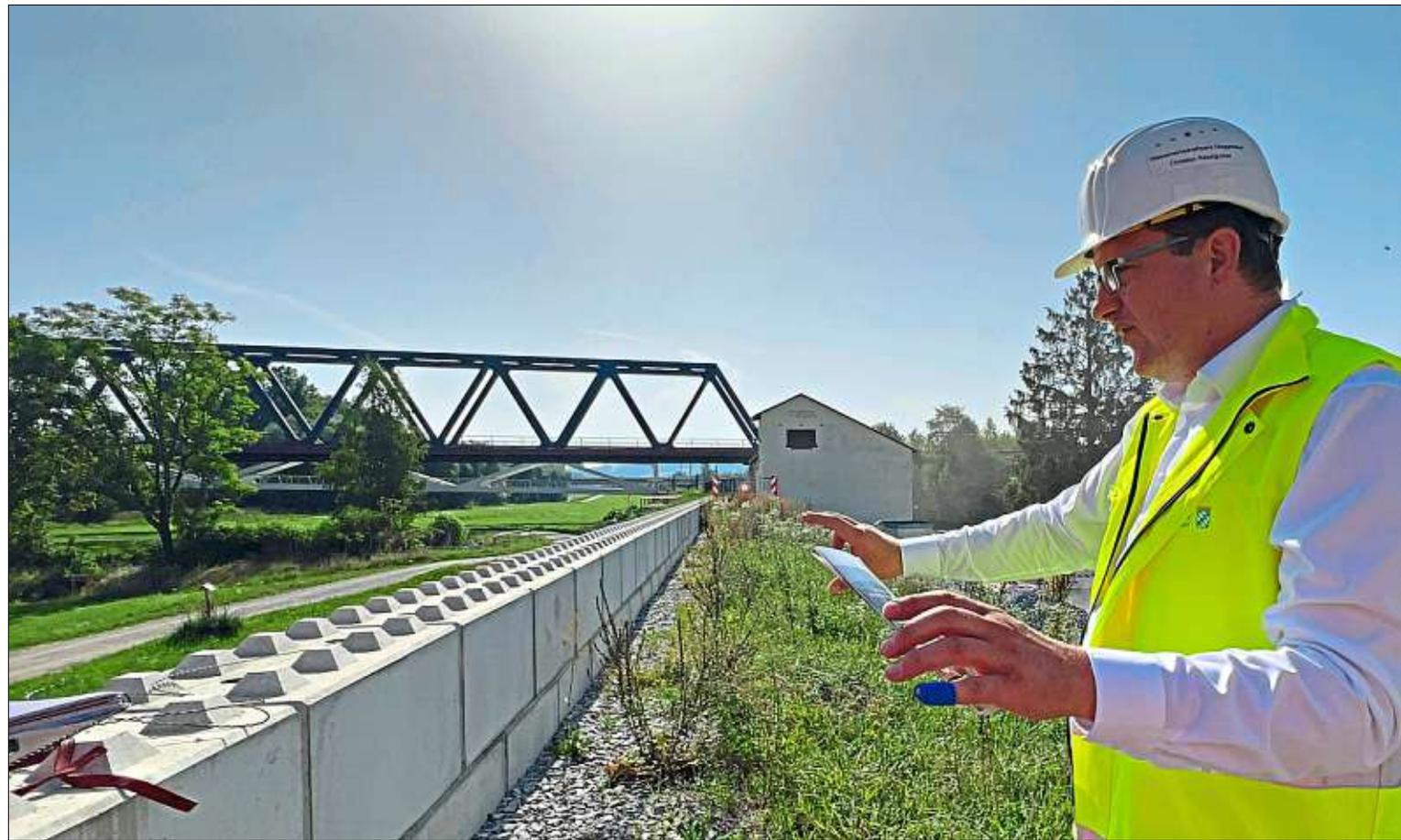
**Kreative Lösung:** Mit Betonsystemblöcken wurde in Natternberg die Lücke zwischen dem alten Schöpfwerk und dem provisorischen Deich um die Baustelle auf HW 100 angehoben.
