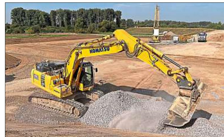
**In Natternberg** arbeiten aktuell Bagger an einem provisorischen Deich, um mit dem Bau des neuen Schöpfwerks starten zu können.
