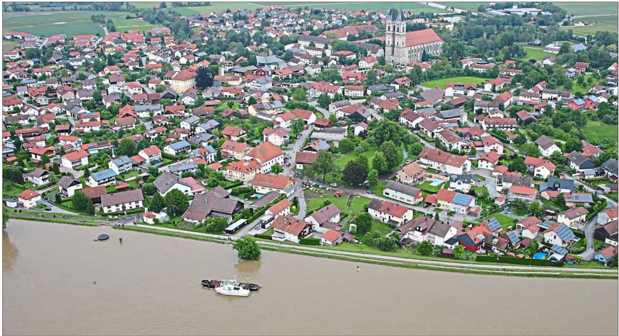
Bedrohlich: Das Luftbild verdeutlicht, wie eine dreieinhalb bis vier Meter hohe Wasserwand Niederalteich gefährdet. Das Hochwasser der Donau steht am Deich bis zur Krone hinauf. Noch ist der Ort trocken, doch bald darauf wurden viele Häuser überschwemmt durch einen Dammbbruch stromabwärts bei Auerwörth.
