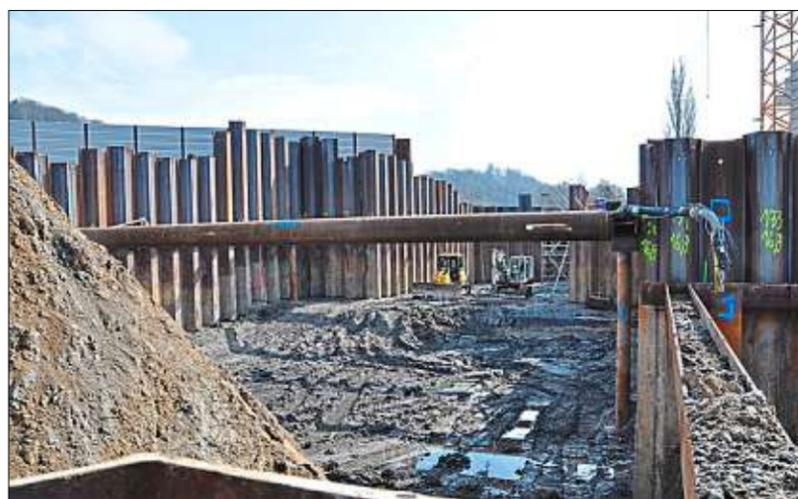
**März 2021:** Die Baugrube für das neue Schöpfwerk ist ausgehoben und mit Stahlwänden abgespundet.
