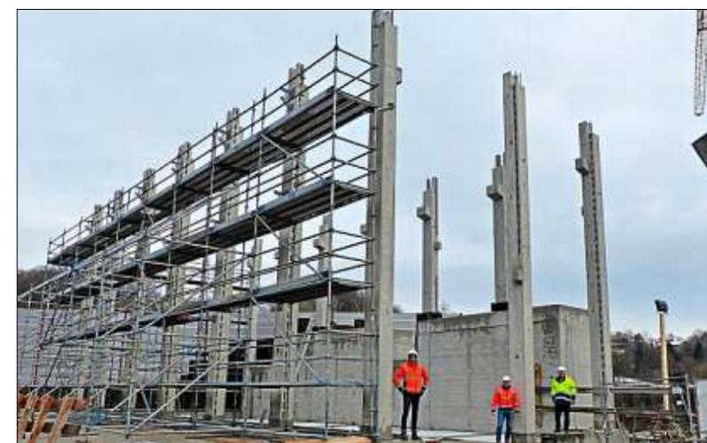
**Dezember 2021:** Der Rohbau ist so gut wie fertig. In das „Gerippe“ wurden noch Fertig-Fassadenelemente aus Beton eingehängt.
