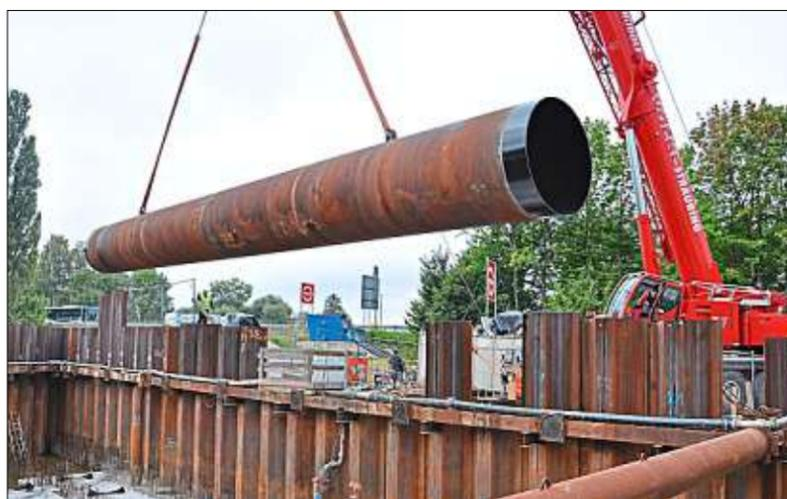
**September 2021:** Die drei riesigen Druckrohre aus Stahl werden eingehoben.
