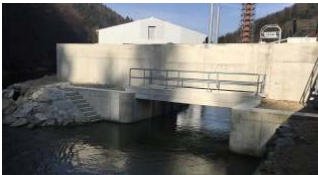
▲ Sielbauwerk an der Ausleitung des Werkskanals
