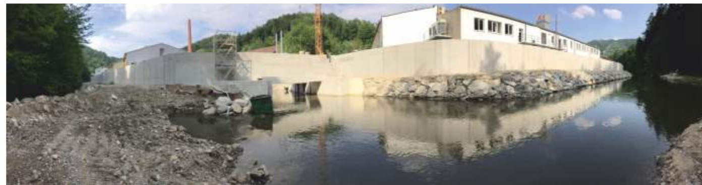
▲ Blick vom linken Erlaulufer - Ufersicherung, Hochwasserschutzwand und Sielbauwerk Foto: Wagmann Ingenieure GmbH
