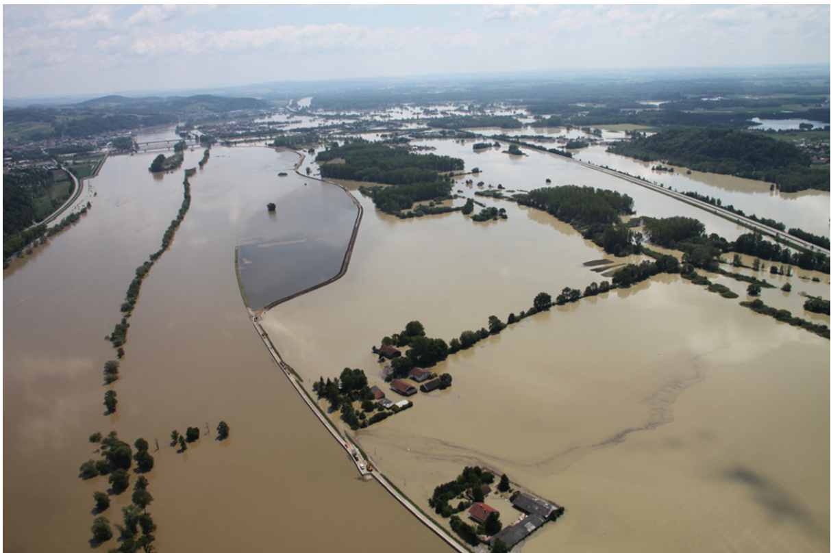
Bild 3: Überschwemmung im Stadtteil Fischerdorf (Quelle: WWA Deggendorf)
