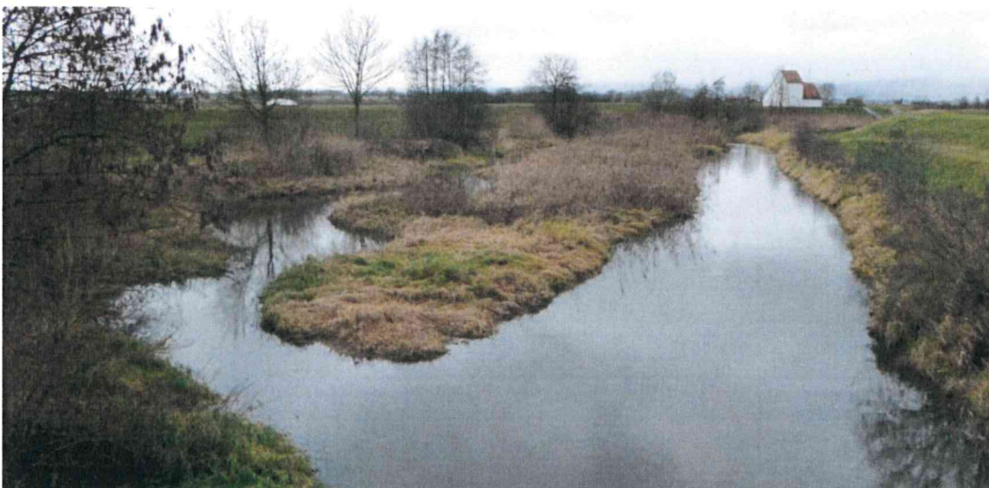
Abb. 7: Geschaffener Seitenarm zur Vorlandgestaltung bei ca. Fkm 3,800 am Kößnach-Ableiter: Zustand heute
