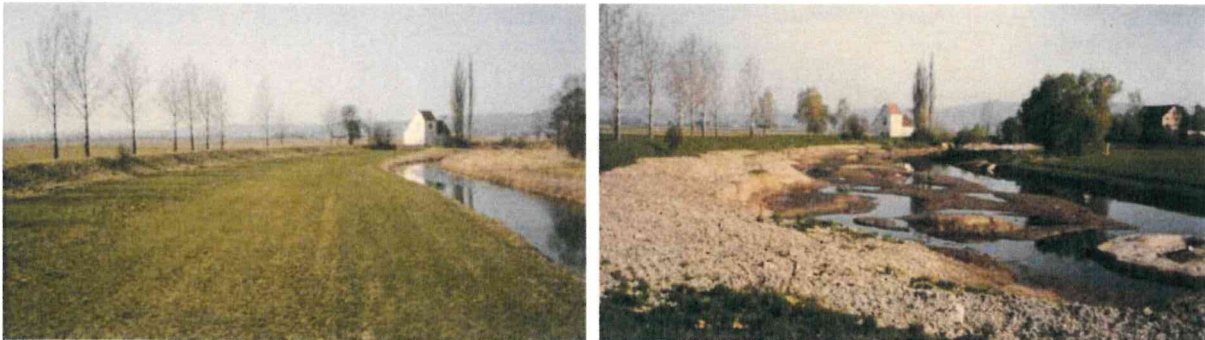
Abb. 6: Vorlandgestaltung bei Schöpfwerk Kößnach. Links: Zustand vor Baubeginn 1986. Rechts: nach Fertigstellung 1987
