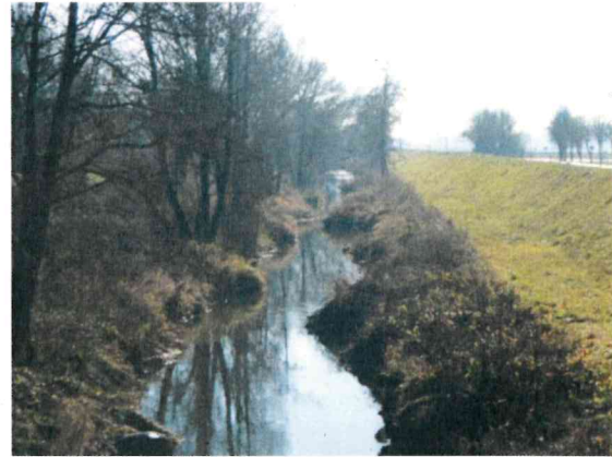
Abb. 4: Abschnitt am Kinsach-Mehnach-Ableiter, an dem bereits Uferstrukturierungen durchgeführt wurden (bei Fkm 3,000; Blick flussabwärts)
