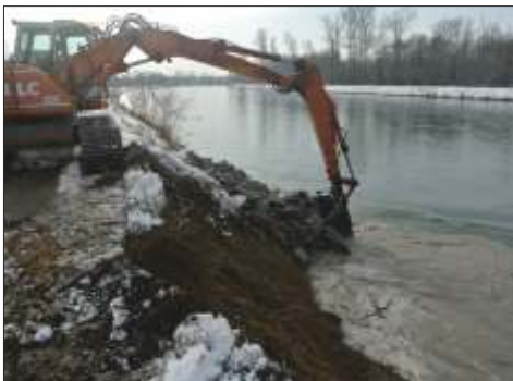
▲ Abb. 13/ 14: Ausbau des Uferverbaus und Renaturierung der Flusssufer
