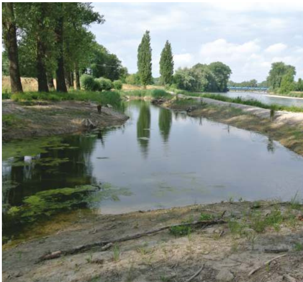
▲ Abb. 8: Entlandung und Wiederanbindung eines Altarmes bei Plattling
